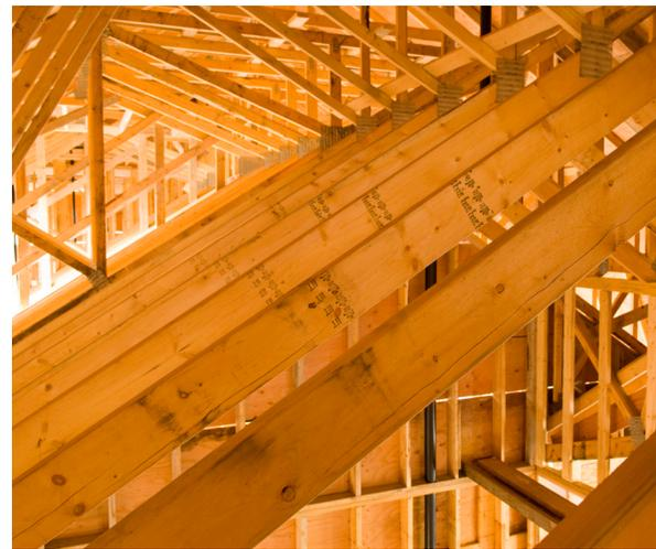
Interfor produit du bois d'œuvre MSR de qualité qui offre une variété de niveaux de résistance et de rigidité pour répondre aux applications d'ingénierie les plus exigeantes dans les fermes de toit et de plancher. Notre bois MSR est produit dans les régions de l'intérieur, de l'est et du sud de la Colombie-Britannique.
