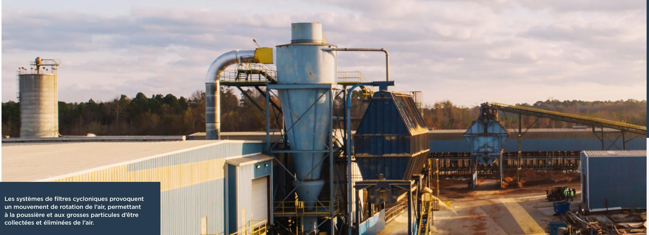
Les systèmes de filtres cycloniques provoquent un mouvement de rotation de l'air, permettant à la poussière et aux grosses particules d'être collectées et éliminées de l'air.
